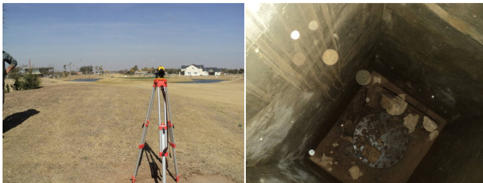
Figura 2. Nivel utilizado para alinear la cañería. Der: Cámara de limpieza de cañería de Aguas Cordobesas
