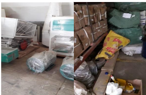
Figura 11. Equipos mal ubicados
