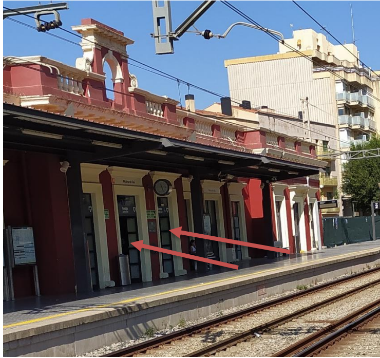
Imatge 99: Portes d'accés a dins de l'estació des de la via 2 | Font: Elaboració pròpia
