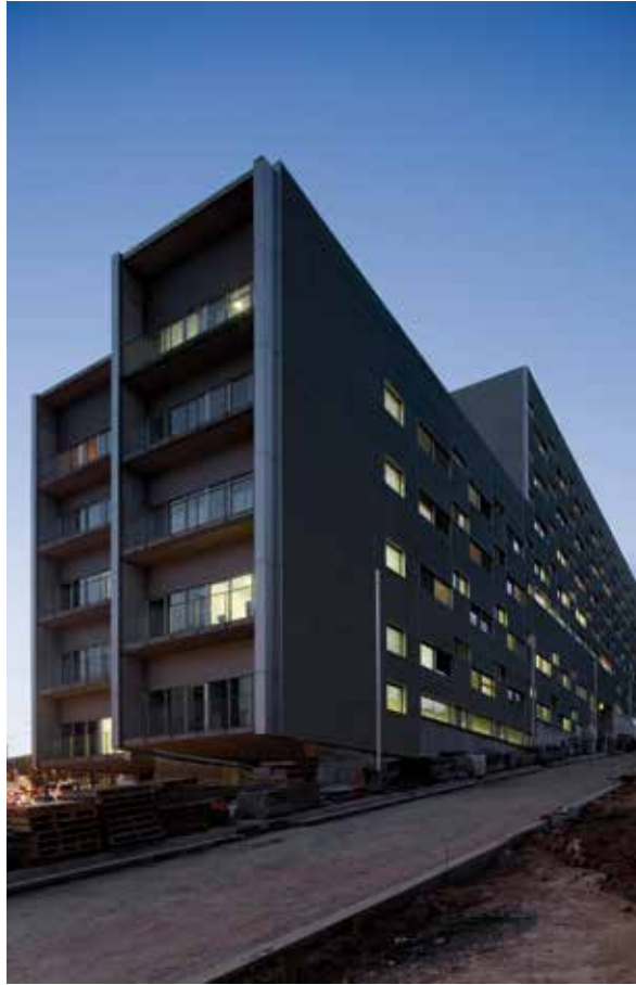
viste dell'ospedale: i due corpi aggettanti e, nella pagina seguente, il lato est ovest views of the hospital: the two jutting out parts and, in the following page, the east-west side of the building
