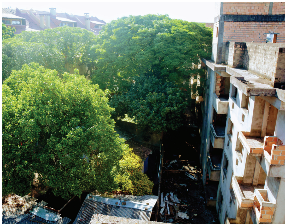
Figura 21 – À esquerda, está a seringueira, símbolo territorial da comunidade, fixado no pátio central do Quilombo. À direita, o prédio, que teve sua obra paralisada, por ocupar parte do território do Quilombo. Fonte: NEGA (2019)
