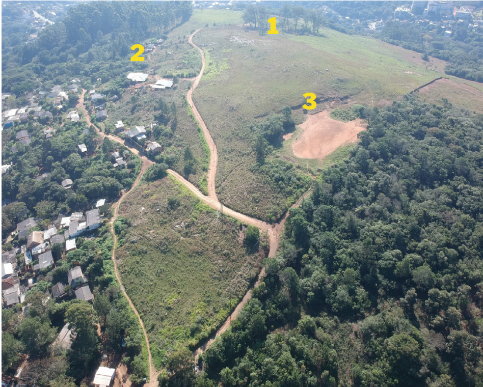
Figura 23 – Vista parcial do território do Quilombo dos Alpes. 1. Capão da Vó; 2. Sede da Associação do Quilombo dos Alpes; e 3. Campinho. Ao longo das ruas, serão construídas moradias do projeto habitacional.
