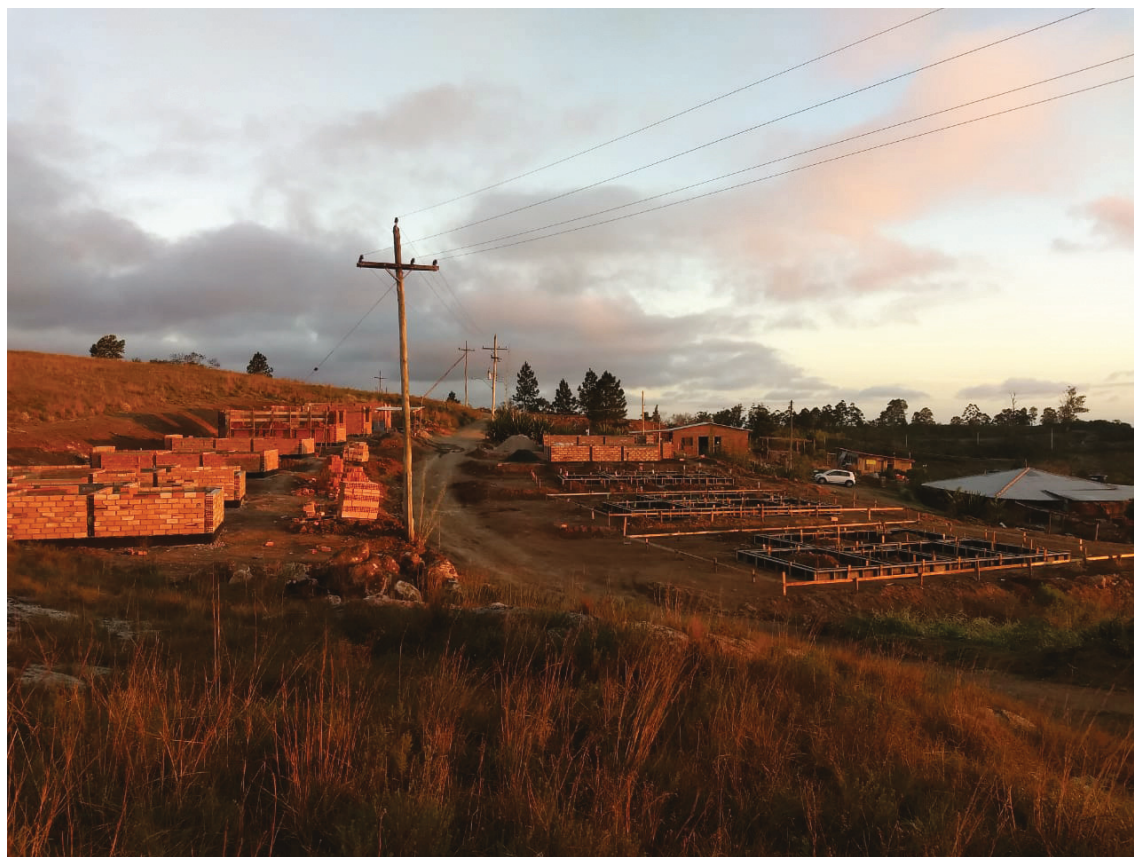
Figura 6 – Registro das obras Fonte: NEGA (2019)
