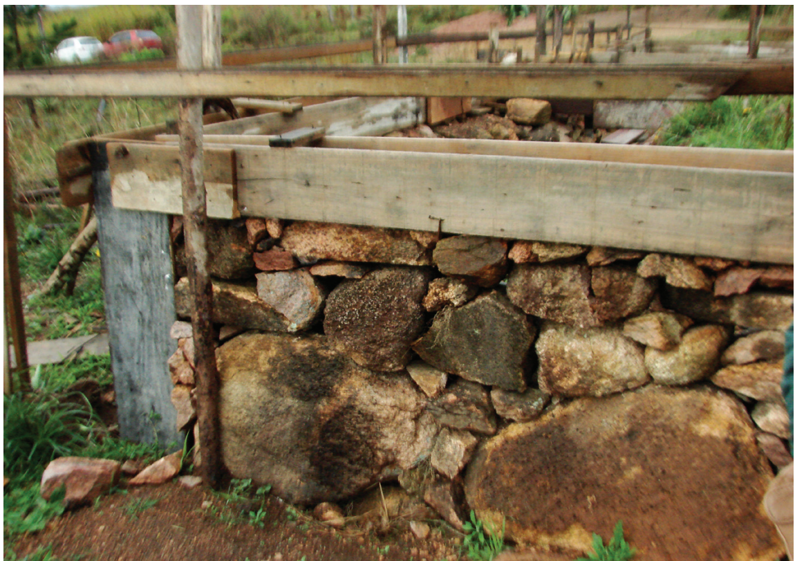
Figura 17 – Taipas, técnica construtiva dominada por Janja
