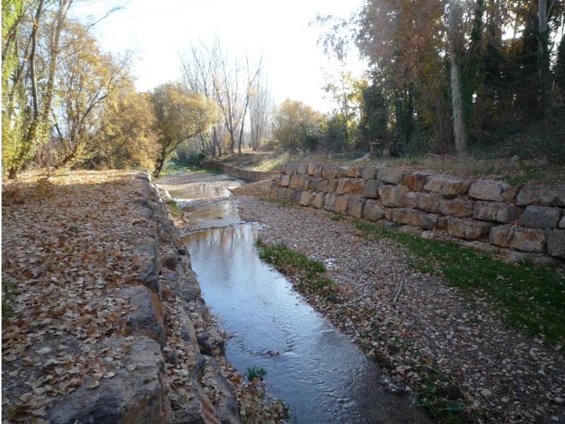
Aspecto actual del primer emplazamiento del azud de San Blas y luego del azud de la fábrica de carburo.
