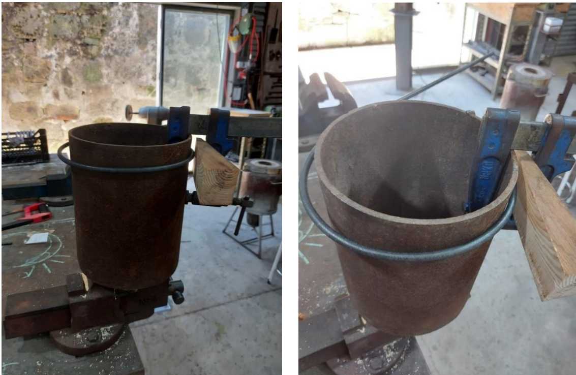
Figura 83 - conjunto de imagens do processo de produção da estrutura.
