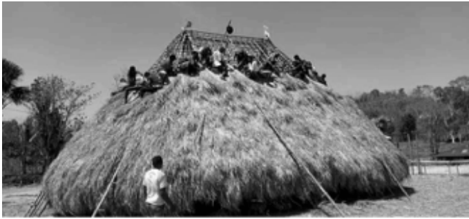
Fotografia 2 – Casa sagrada de Leowes em construção. Fonte: acervo pessoal dos autores. Data: dezembro/2016.
