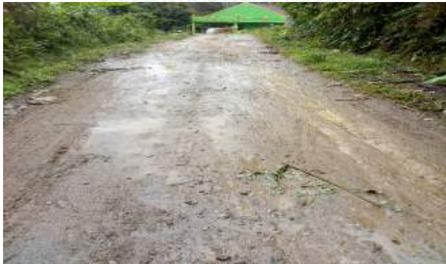
Objek Penelitian: Kondisi Infrastruktur Jalan
