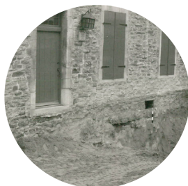
1980- Milot (C&É-109-4A2) Vue d'ensemble des fondations et du soupirail. (En direction Sud-Est).
