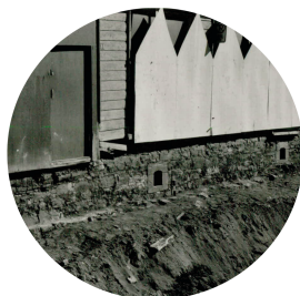
1980- Paradis : Vue générale des fondations de la maison avec les soupiraux. En direction Sud-Est. (Photo S. Rouleau, A66-30 #11)
