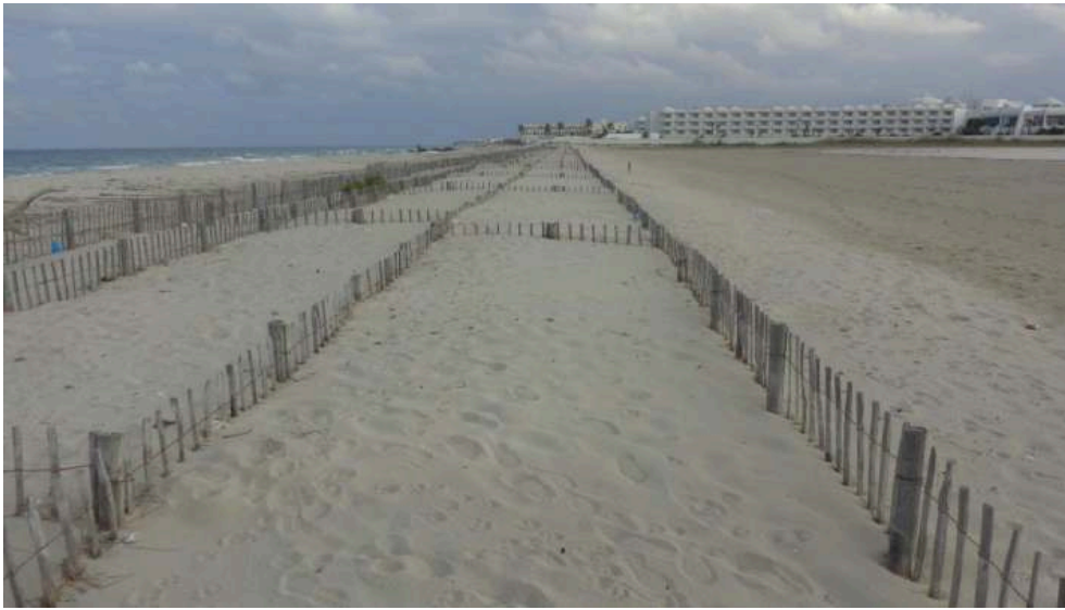
Figure 15 - Les ganivelles installées au niveau de la racine de la flèche de Rass Errmal (la situation en novembre 2015 et en juillet 2017 (clichés : Z. Akacha) : un piégeage assez rapide du sable ; sur la photo de juillet 2017, les ganivelles commencent à être enterrées.
