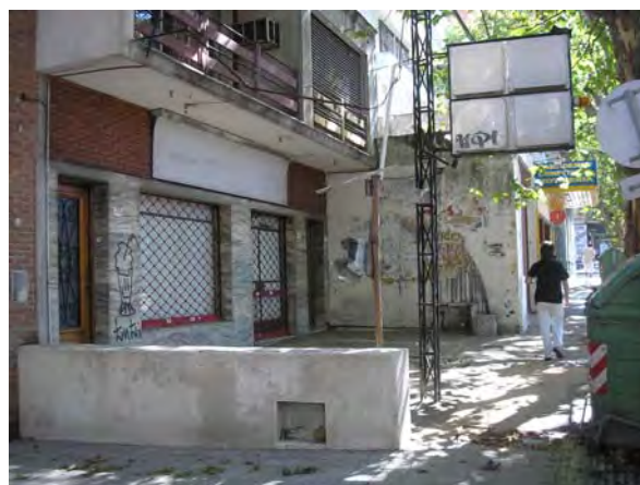
Área comercial deteriorada – Calle Pereira
