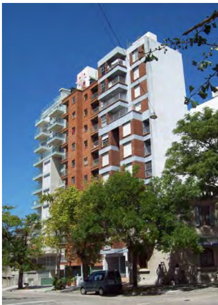
Pantalla de edificios sobre Sarmiento
