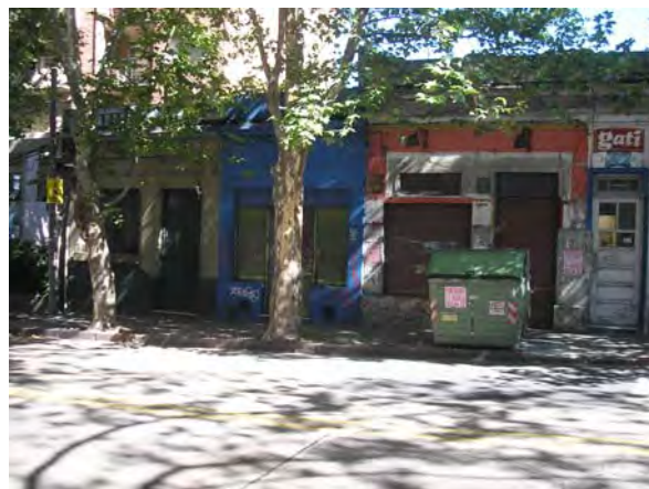
Área comercial deteriorada – Calle Rivera
