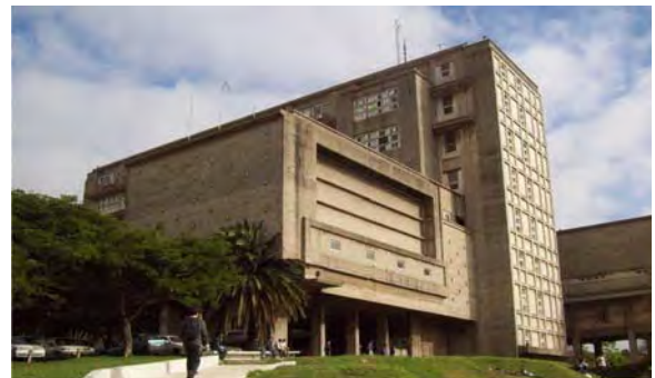
Vista del acceso desde el norte
