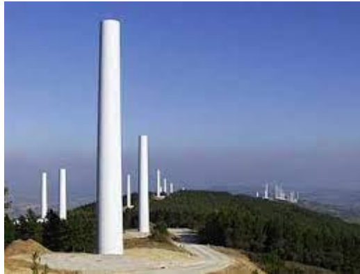
Figura 13. Torres de aerogeneradores
