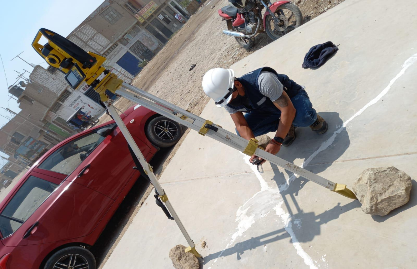
Foto 03: Ubicación de coordenadas para iniciar levantamiento topográfico
