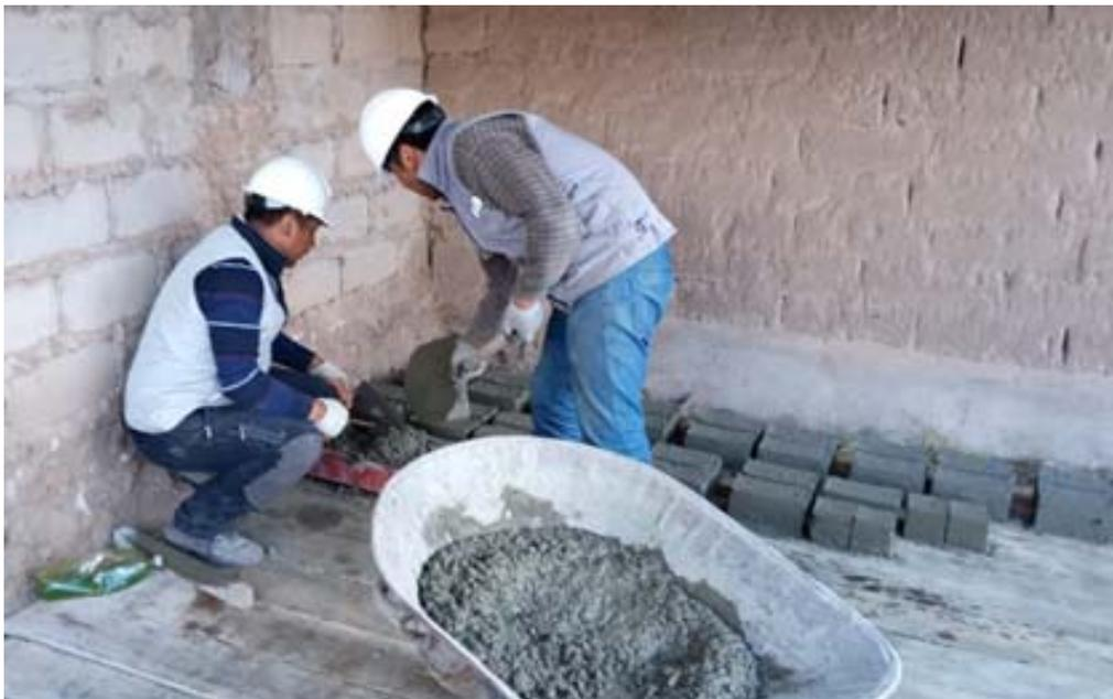
**Fotografía 26.** *“Elaboración de ladrillos de concreto”*
