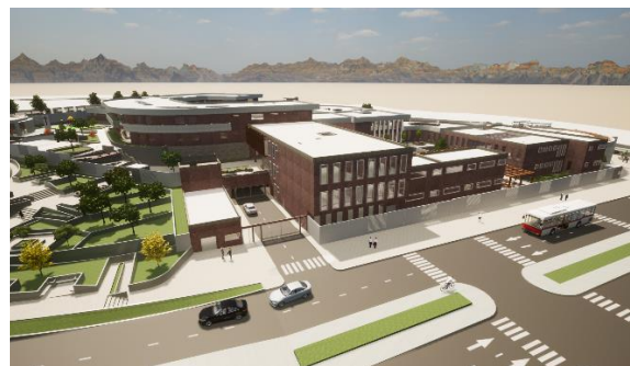
Ingreso N°6 – Ingreso a Estacionamiento
