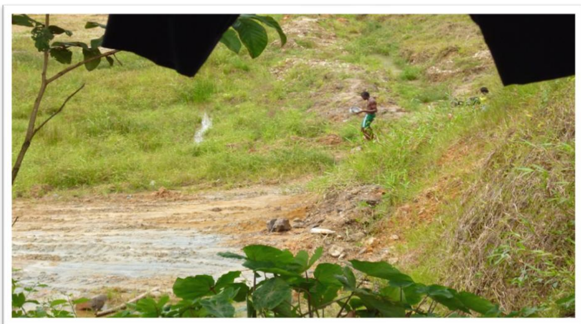
Foto N°11. Pozos de Reserva de Agua Cristalina.
