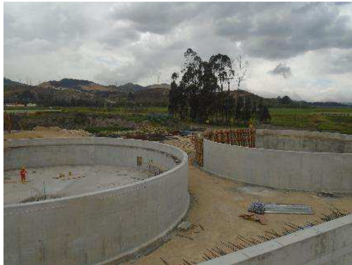
Figura 8. Estructuras en concreto reforzado, su construcción tiene un método comparable entre los dos proyectos referencia.
