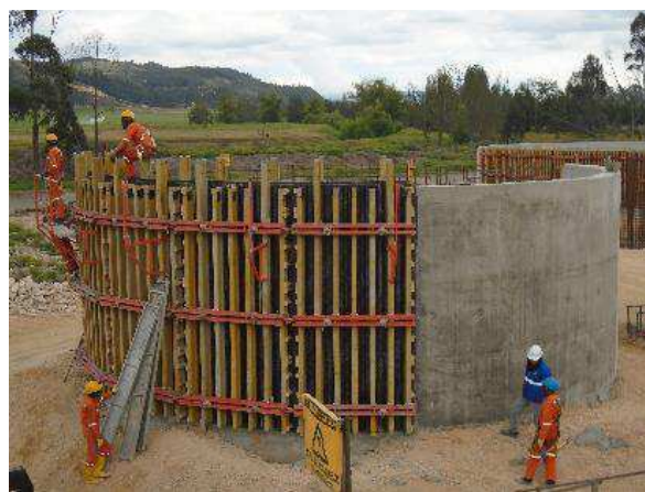
Figura 9. Estructuras en concreto reforzado, su construcción tiene un método comparable entre los dos proyectos referencia.
