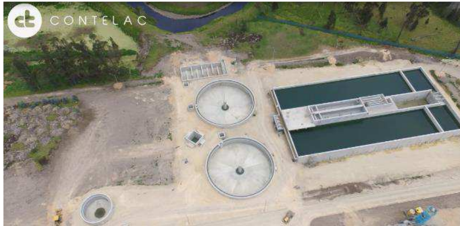
Figura 10. Proyecto en su estado actual, con un porcentaje de ejecución del 90%
