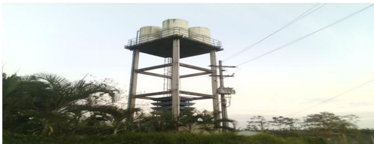
Tanque elevado de la vereda la pola
