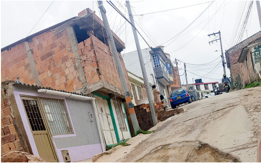
Figura 3. Vía en mal estado y postes de luz en lugares inadecuados (Carrera 2e)
