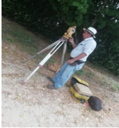
Fotografía 9 Realización de la Topografía. Fuente: Propia
