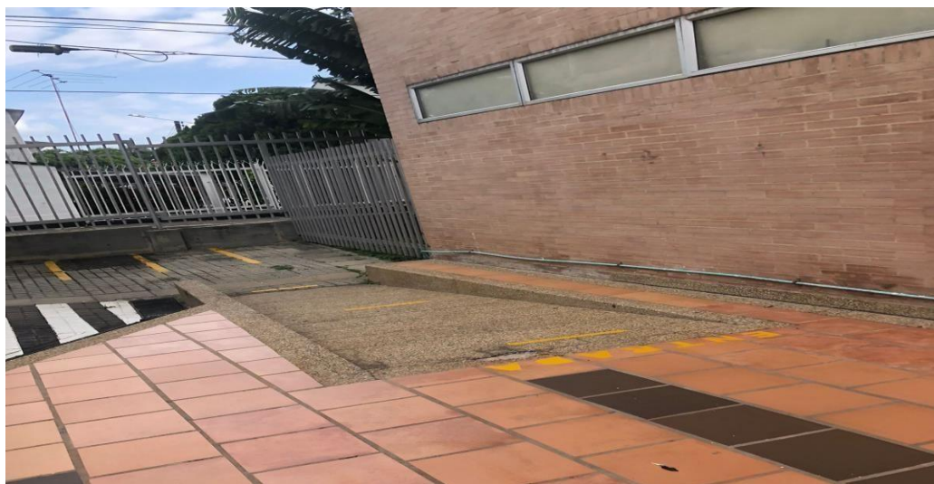
Figura 13: Rampa de acceso a la UMD para personas con limitaciones físicas
