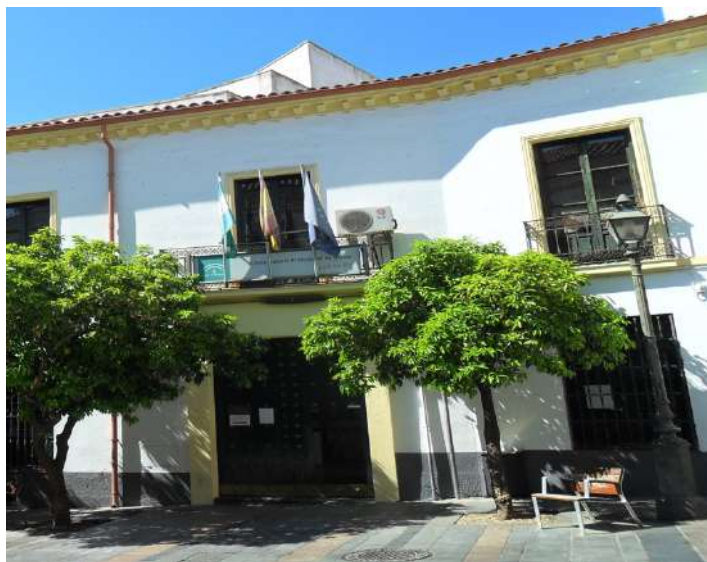
Figura 11. Fachada principal del CPD "Luis del Río".
