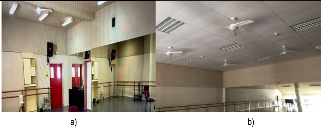
Figura 46. a) Diferentes tipos de luminarias; b) Iluminarias en estructura de techo desmontable.
