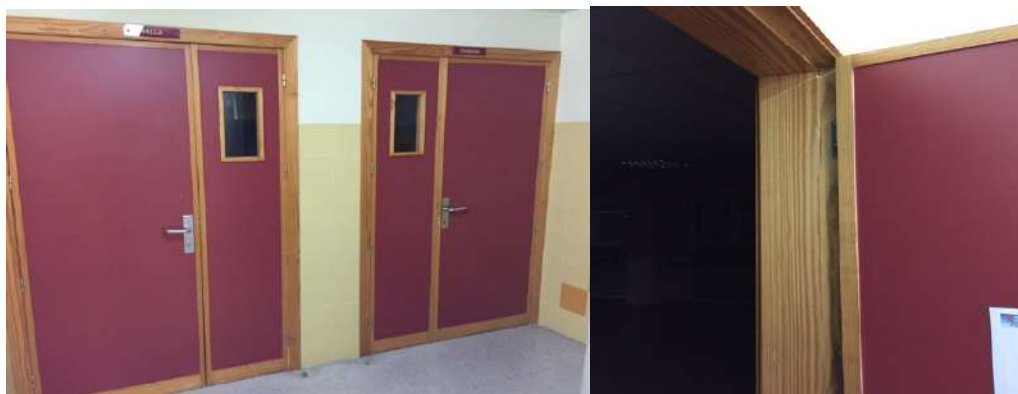
Figura 32. a) Ventanillo con cristal; b) Puerta exterior de aulario con apertura hacia el exterior.
