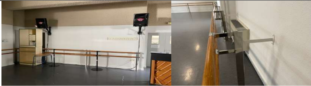
Figura 50. a) Barra doble con pie.; b) Sujeción de barra con garra a la pared.
