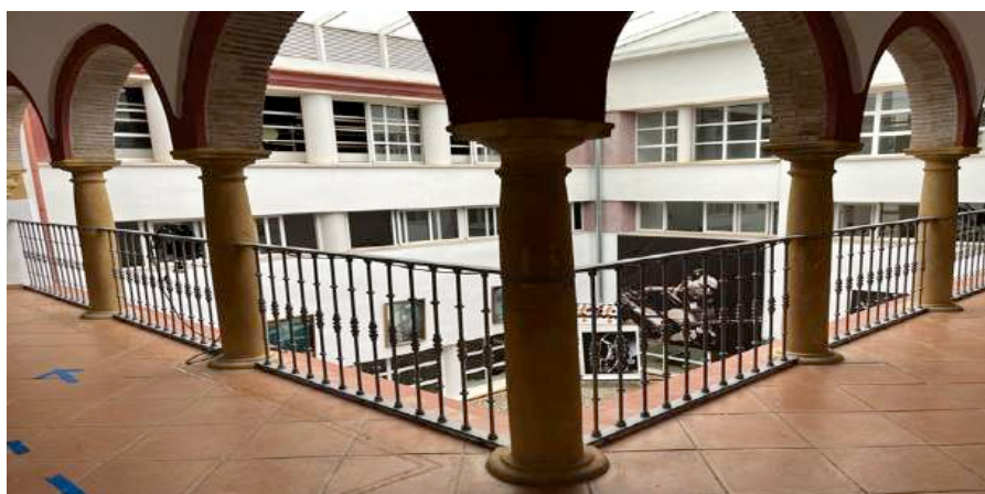
Figura 64. Galería claustral señalizada. CPD de Córdoba.2021.
