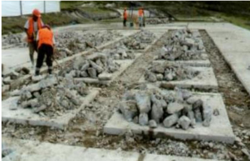
FOTOGRAFIA 3: Inicio de obra 17/09/2014. FUENTE: Página Web de INFOBRAS de La Contraloría.
