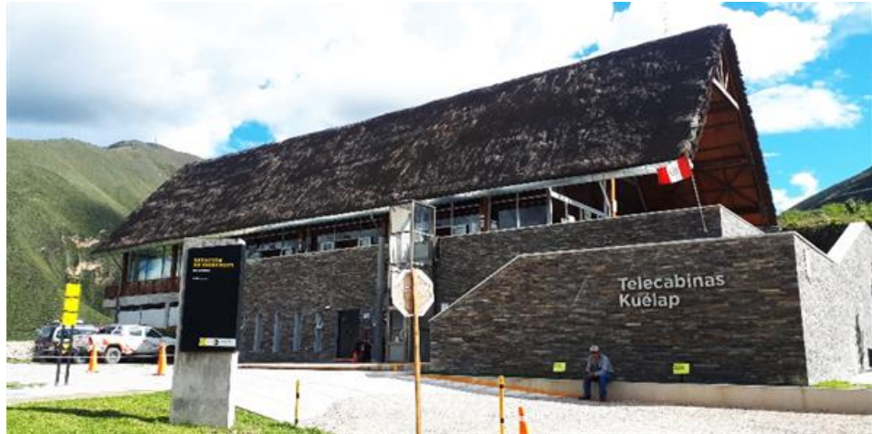
FOTOGRAFIA 28: Estación de embarque de Telecabinas Kuelap. FUENTE: Fotografía Propia.
