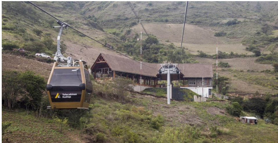
FOTOGRAFIA 29: Vista externa de andén de salida. FUENTE: ArchDaily.
