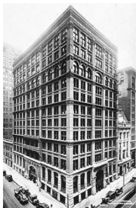
Imagen N°4. : Edificio Home Insurance
