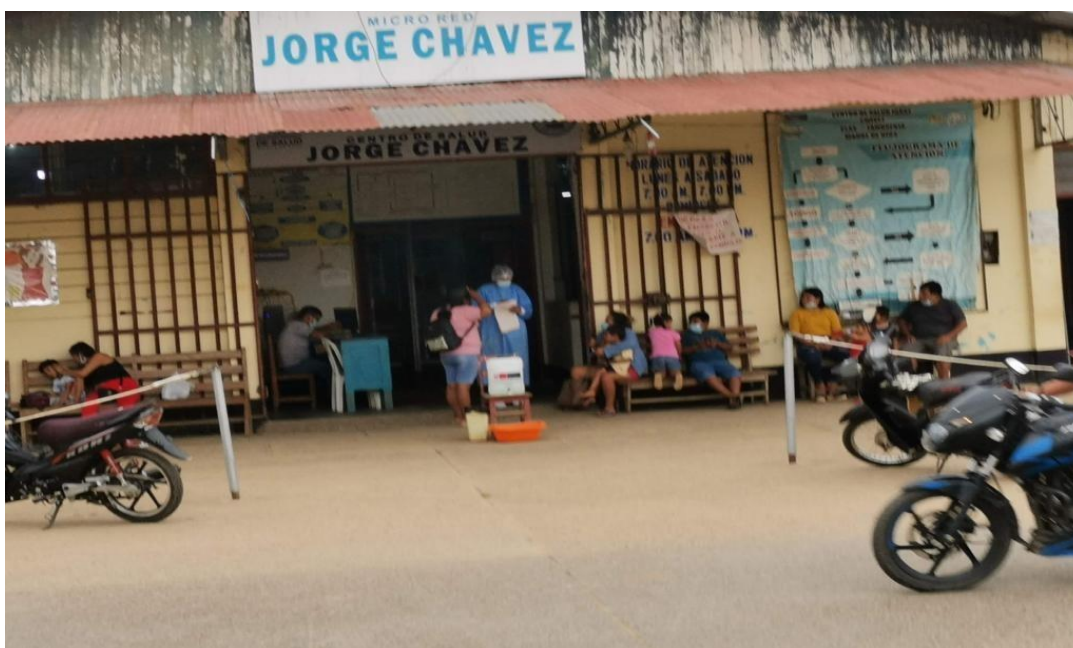
Figura.19 CENTRO DE SALUD JORGE CHAVEZ, PROVINCIA Y DISTRITO DE TAMBOPATA, PUERTO MALDONADONADO
