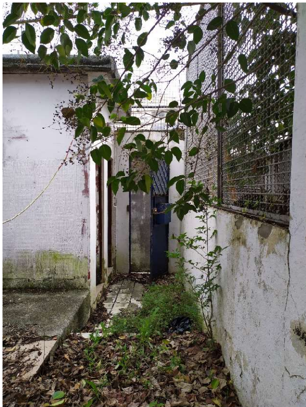
Fig.16. Fotografias da “ilha no Campo Alegre”. A situação de abandono e ausência de manutenção agrava a degradação, tem motivado invasões e o aparecimento de pestes.
