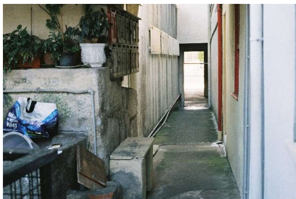
Fig.22. Fotografias da “Ilha no Campo Alegre”. Condições de acessibilidade e segurança.
