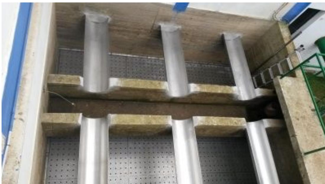
Figura 12: Filtro de Arena de Gravedad (Fuente: Esmotec)
