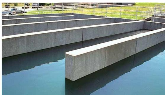
Figura 18: Tanque de Cloración (Fuente: iAgua)
