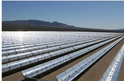
Ilustración 30: Colector Cilindro Parabólico
