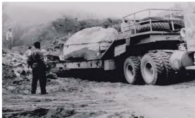
Figura N° 32. Parte del proceso constructivo de la obra. 1963. Fuente: https://issuu.com/cmncasos/docs/lorenzo_berg/161
