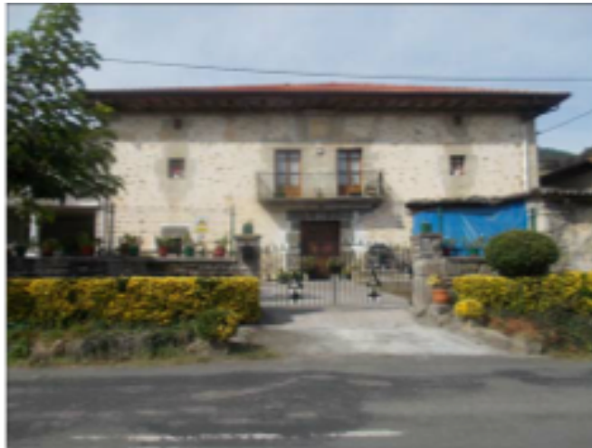
Casa solariega de Revilla-Presa en Retes de Llanteno 771
