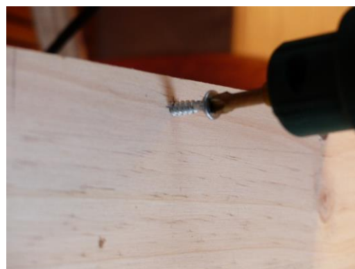
Ilustración 27- Taladrado y atornillado de las patas a la estructura
