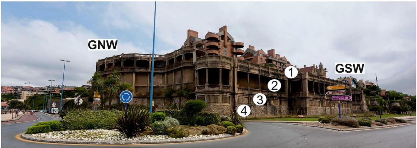
Fig. 4 – Vista exterior de las Galerías Punta Begoña centrada en la GSW, pudiendo diferenciar sus diferentes elementos (de arriba abajo): <sup>1</sup>plazoleta-mirador circundada de balaustrada, <sup>2</sup>galería, <sup>3</sup>muro de hormigón y <sup>4</sup>muro de mampostería. (Tomado de Getxo Punta Begoña Galeriak: <http://puntabegonagetxo.eus/es/home-es/>)
