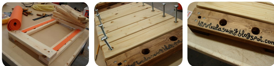
Figuras 89 a 91: Proceso de construcción de la Txalaswing
