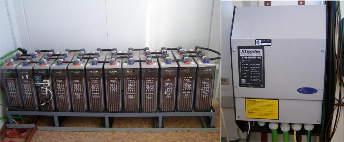
Figura 41. Imagen de la bancada de baterías de Plomo-Ácido y el inversor-cargador asociado del ramal de la caseta en el CT-PEPAIII del CEDER-CIEMAT [117].
