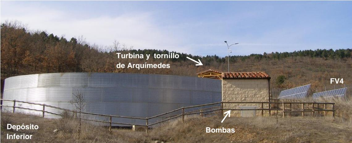
Figura 42. Imagen del ramal de la zona bombeo-turbinado en el CT-PEPAIII del CEDER-CIEMAT.
