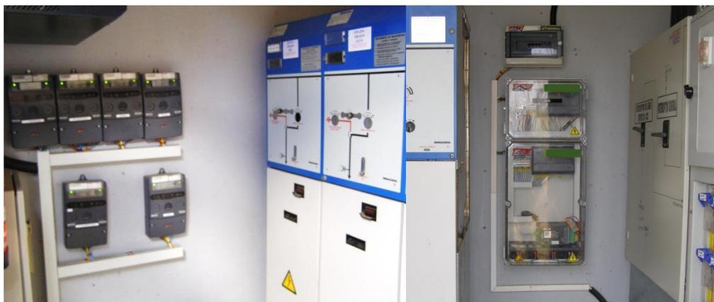
Figura 29. Fotografías con la instalación de SMs y concentradores de datos en la microrred del CEDER-CIEMAT.
