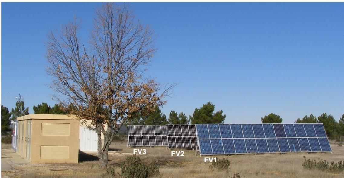
Figura 39. Imagen de las tres pérgolas fotovoltaicas, FV1, FV2 y FV3, del ramal de la caseta en el CT-PEPAIII del CEDER-CIEMAT.
