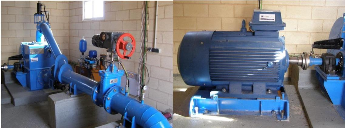
Figura 44. Imagen de la turbina hidráulica y su generador asociado de la zona bombeo-turbinado en el CT-PEPAIII del CEDER-CIEMAT [118], [119].
