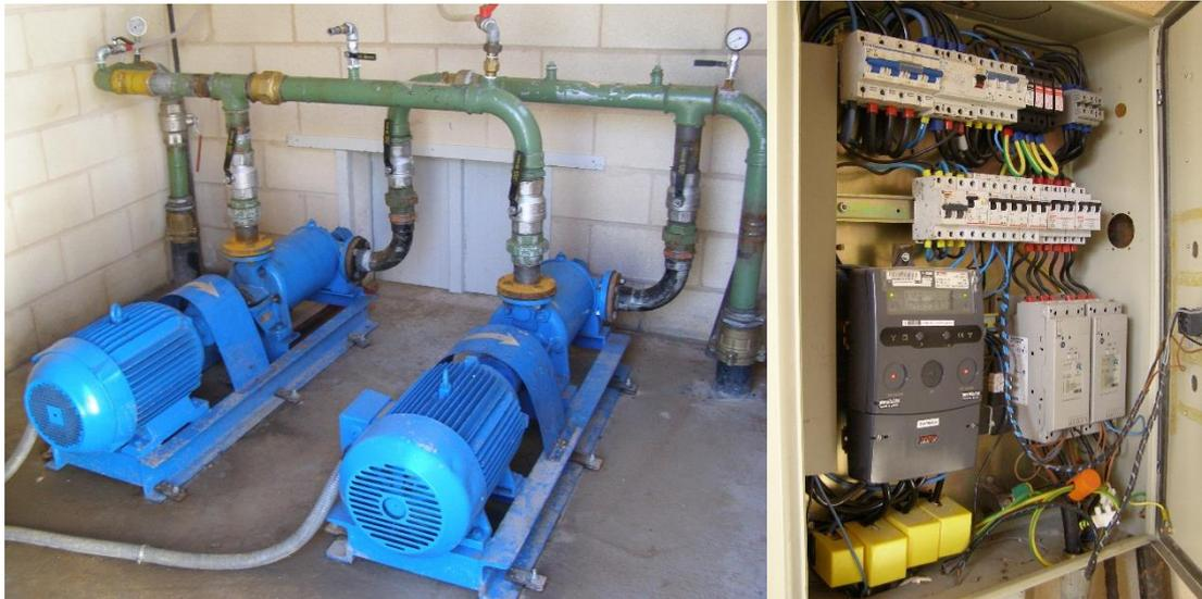
Figura 47. Imagen de las bombas hidráulicas y su cuadro eléctrico de la zona bombeo-turbinado en el CT-PEPAIII del CEDER-CIEMAT [121].
