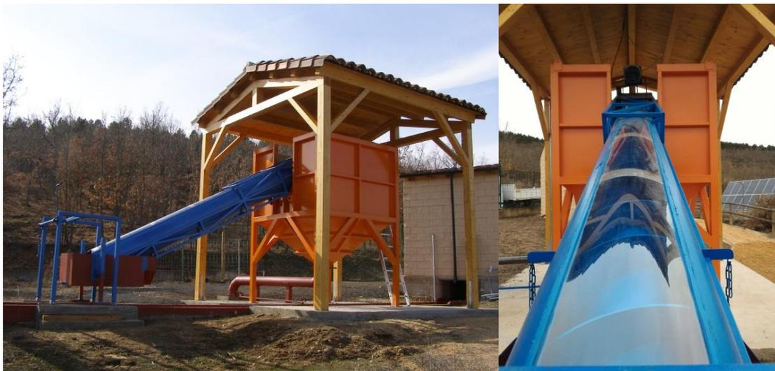
Figura 46. Imágenes de la turbina hidráulica basada en el tornillo de Arquímedes de la zona bombeo-turbinado en el CT-PEPAIII del CEDER-CIEMAT.
