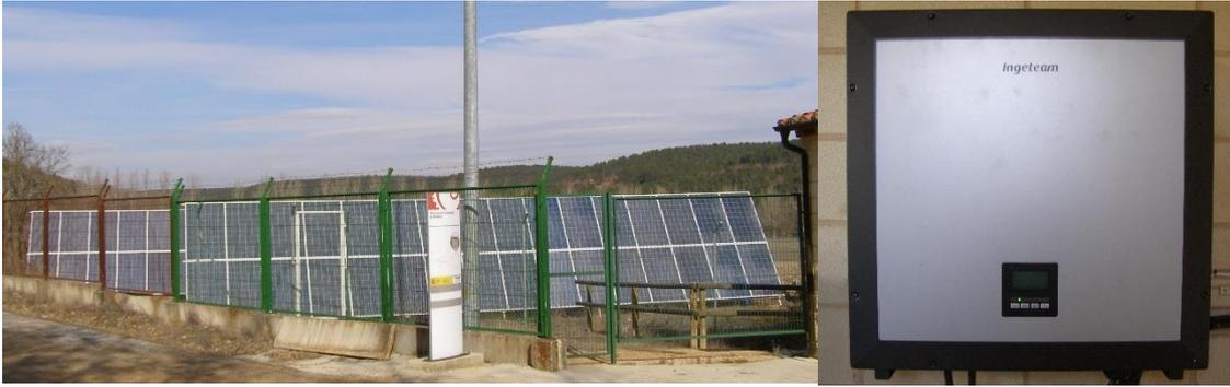
Figura 43. Imagen de la pérgola fotovoltaica FV4 y su inversor asociado de la zona bombeo-turbinado en el CT-PEPAIII del CEDER-CIEMAT [116].
