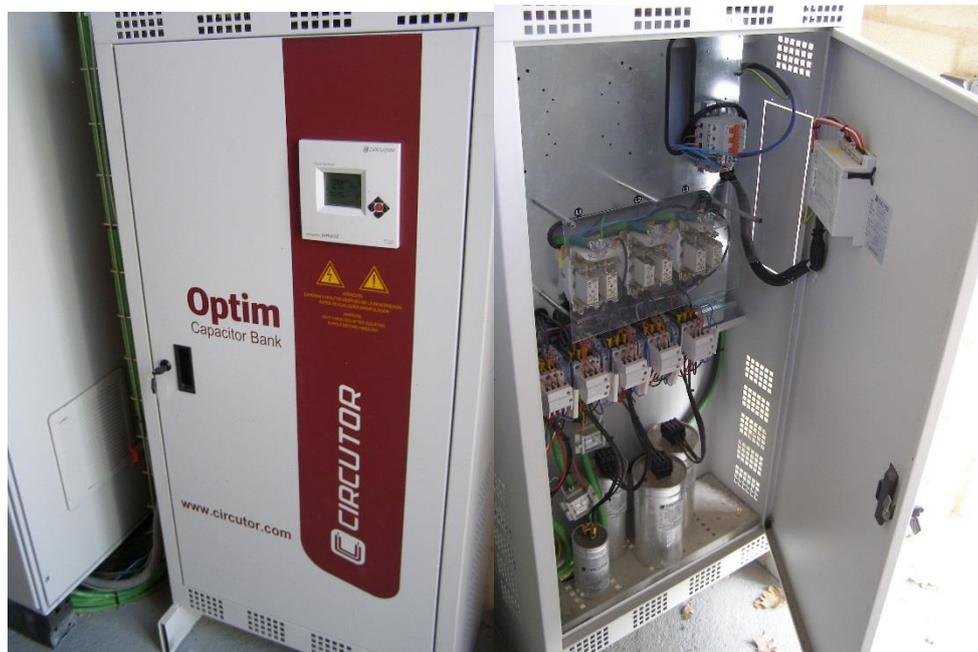
Figura 45. Imágenes del armario de condensadores de la zona bombeo-turbinado en el CT-PEPAIII del CEDER-CIEMAT [120].
