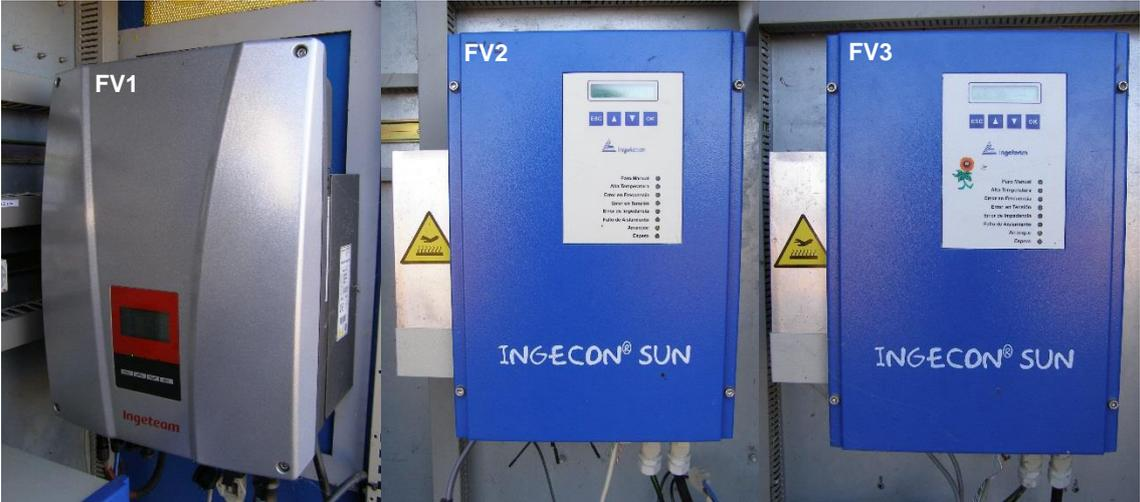
Figura 40. Imágenes de los tres inversores fotovoltaicos de las pérgolas FV1, FV2 y FV3, respectivamente, del ramal de la caseta en el CT-PEPAIII del CEDER-CIEMAT [116].
