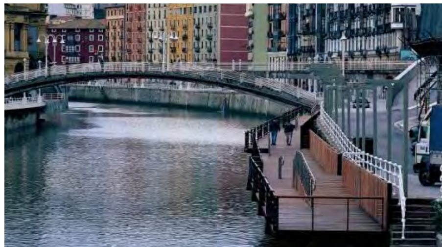
Reurbanización Muelles BLV. Juan Sádaba y José Luis Burgos
