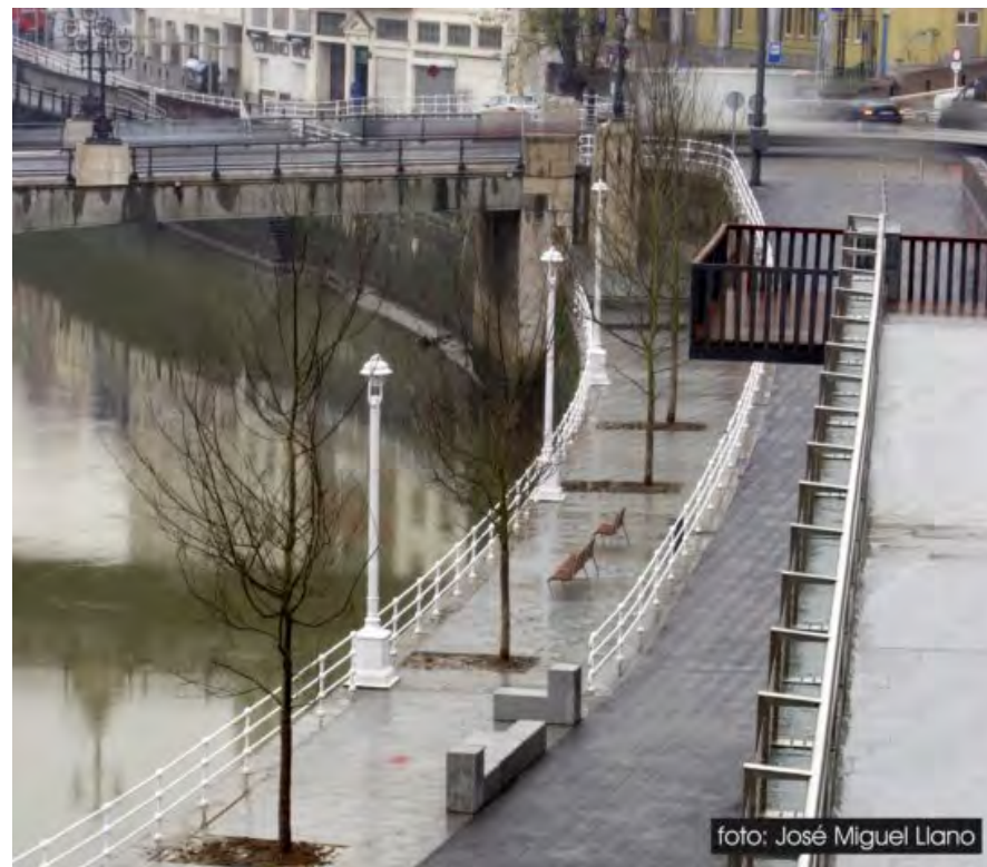
Reurbanización Muelles BLV. Juan Sádaba y José Luis Burgos
