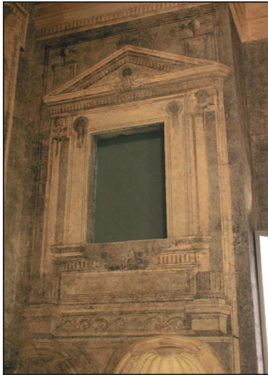
Arquitectura fingida. Paredes laterales del paño norte
