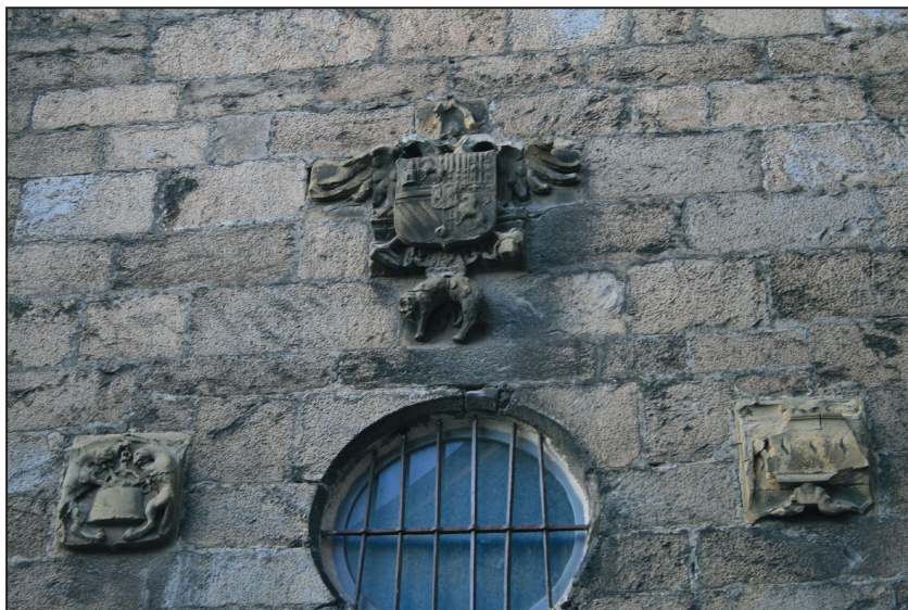
Exterior de la capilla previa restauración de las cartelas y escudo
