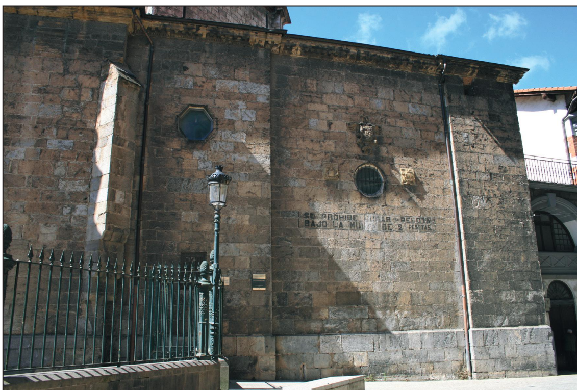
Exterior de la capilla de Santa María
