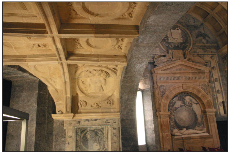
Bóveda del sotocoro
