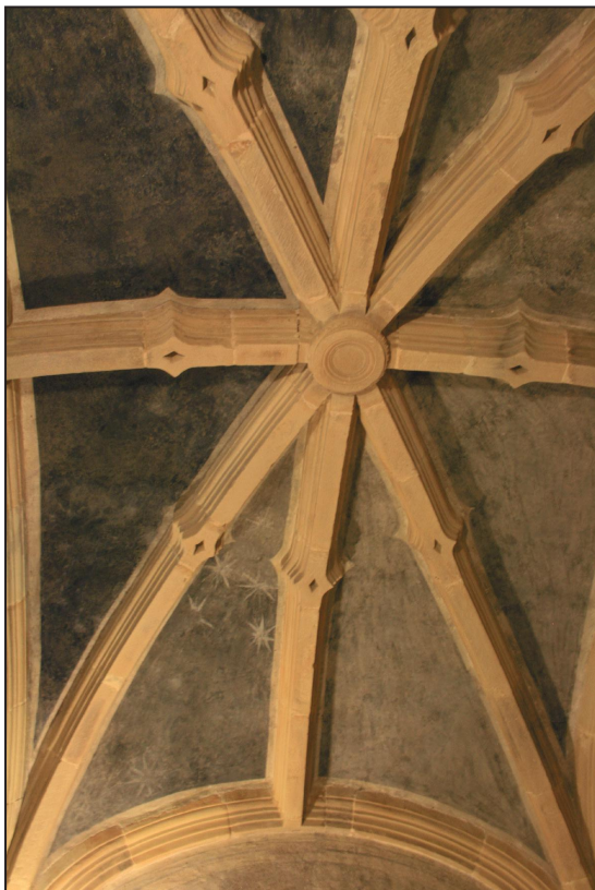
Bóveda de la sacristía
