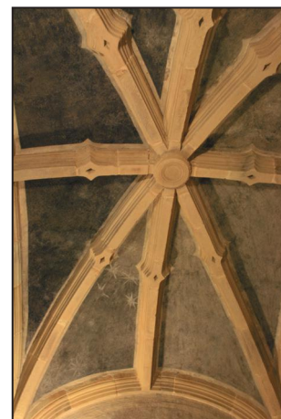
Bóveda de la sacristía
