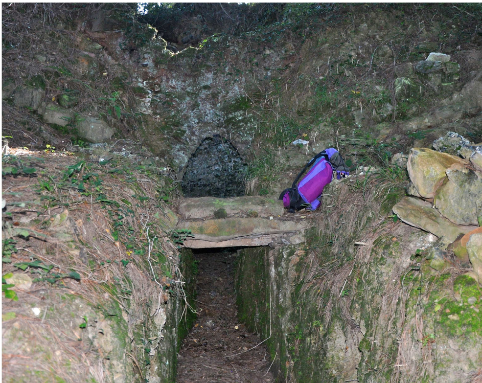
Figura 2: Ejemplo de una ferrería de monte; vista de la abertura frontal y del canal del horno de Azarola en Galdakao (Foto, P. Gil)
