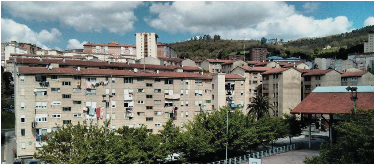
Fig. 4. 1. General view of Otxarkoaga
