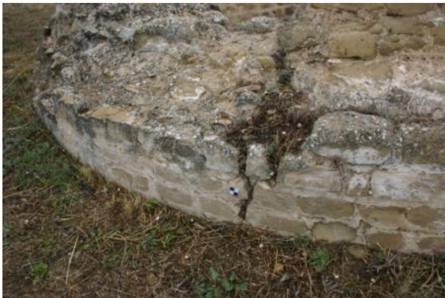
Fig. a.6. Daños estructurales presentes en la exedra occidental del Mausoleo.
