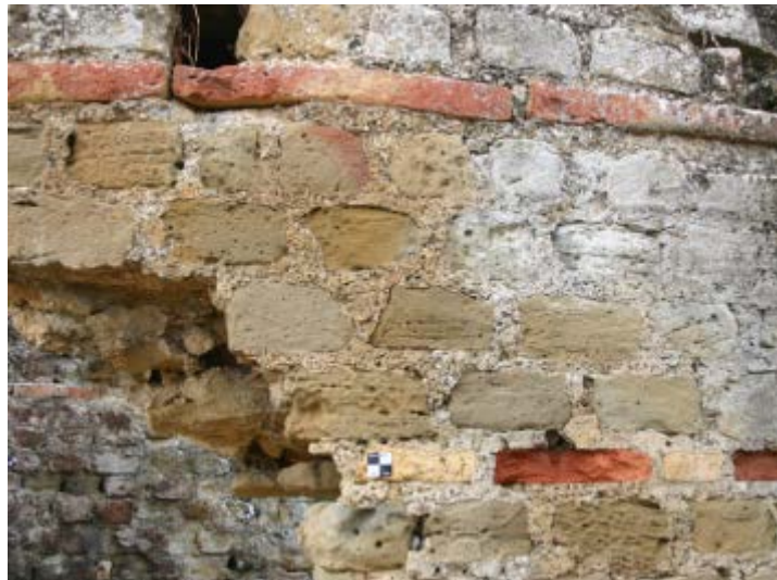
Fig. a.3. Fenómenos de alveolización en la exedra oriental.
