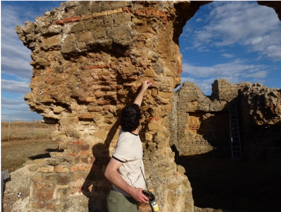
Fig. 5.- Colocación de las dianas en los alzados del edificio.
