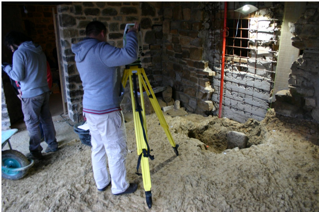
Fig. 5.- Toma de datos mediante estación total.
