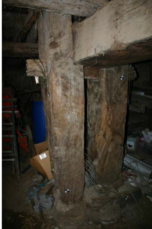
Fig. 3.- Elementos de la prensa de sidra reutilizados en el interior del edificio.
