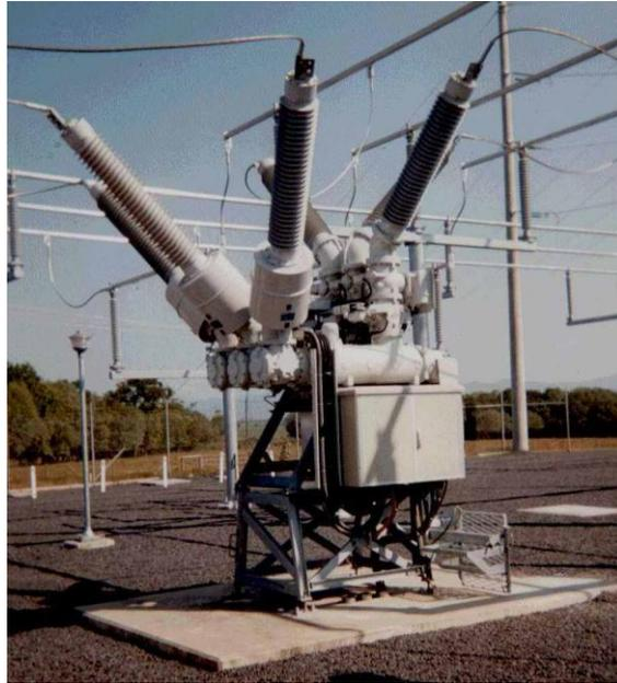
El término **gas** aparece en la definición de este tipo de dispositivos debido a que en su interior, que permanece absolutamente estanco, se crean atmósferas de gases muy aislantes destinados a evitar los problemas de las fuertes descargas que pueden producirse en su seno. Entre los gases más empleados se encuentra el hexafluoruro de azufre ( $\text{SF}_6$ ). Tanto es así, que prácticamente el 80% de la producción mundial de este gas se emplea para estos usos.
