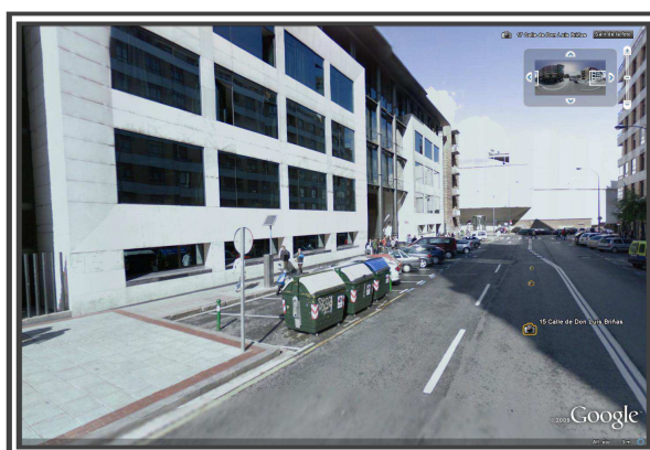
Figura 66. Entorno del edificio D.
