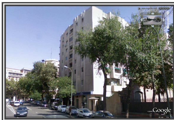
Figura 58. Entorno del edificio MD3.
