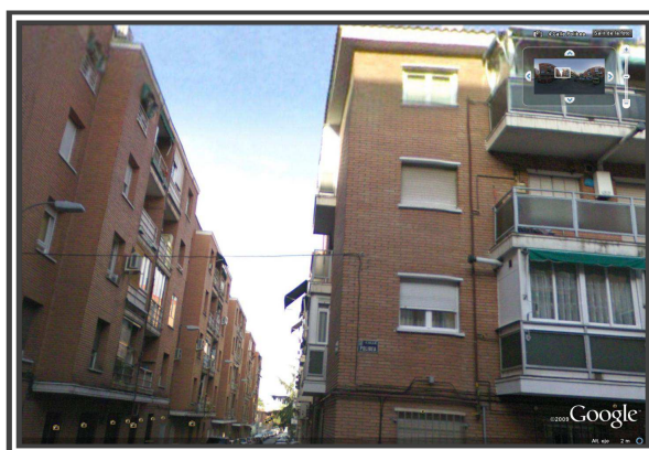
Figura 56. Entorno del edificio MD1.
