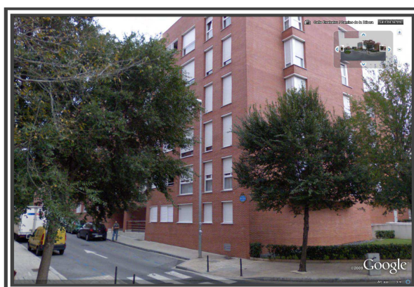
Figura 72. Entorno del edificio J.
