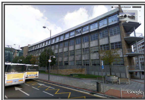
Figura 65. Entorno del edificio C.
