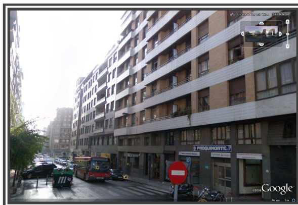
Figura 71. Entorno del edificio I.
