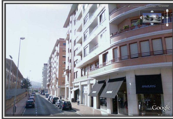
Figura 73. Entorno del edificio K.
