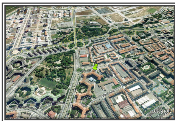
Figura 81. Entorno del edificio S.
