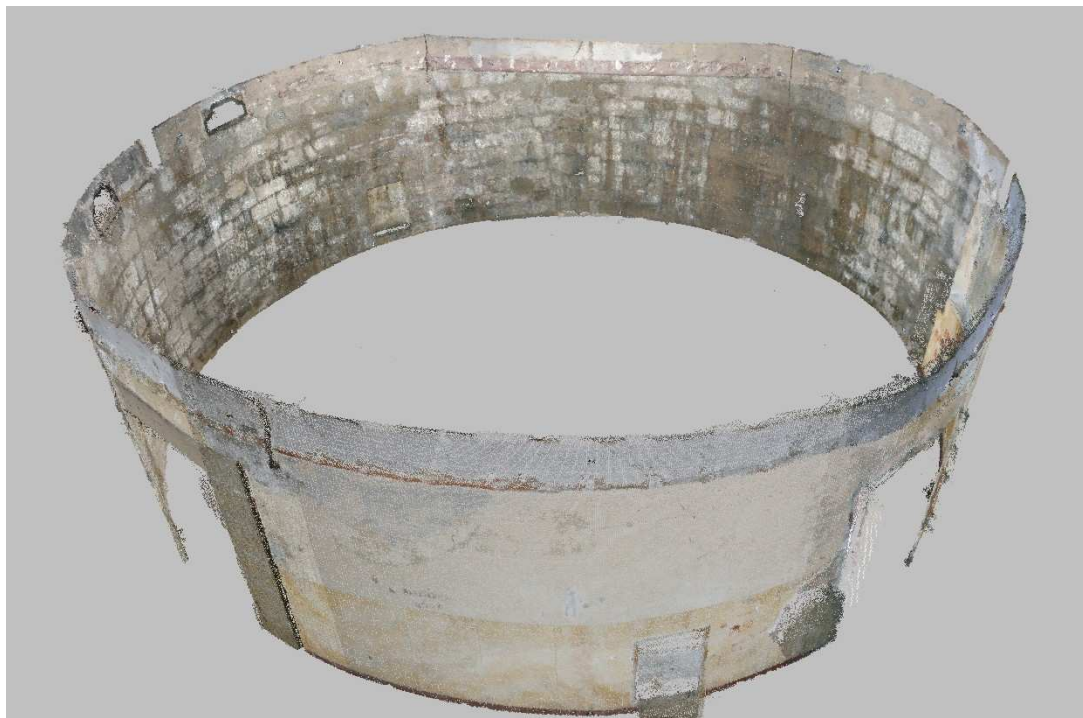
Figura 10.- Archivo unificado de nube de puntos con medias y desviaciones típicas ajustadas. Cubo del Revellín (Logroño).
