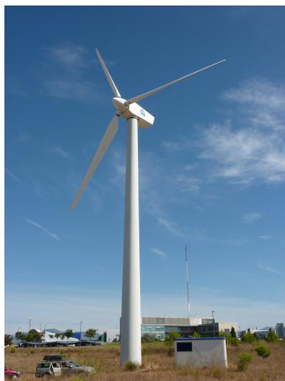
Figura 3.2. Fotografía del aerogenerador VESTAS V29.
