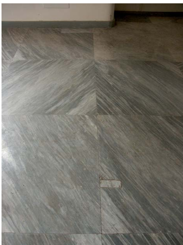
FIGURA 26 • Roma, ex "Casa Gil" a Trastevere. Dettaglio delle piccole risarciture effettuate per integrare le lacune della pavimentazione, in lastre di marmo bardiglio, causate dalla impropria destinazione d'uso dell'edificio. Con l'intervento di restauro si è preferito conservare e reintegrare, piuttosto che ripristinare, le lastre danneggiate, poiché si tratta di rivestimenti autentici ricchi di valenze testimoniali ed estetiche; inoltre, nonostante il fatto che le parti degradate attestavano un periodo di decadenza, ma comunque significativo, dell'opera, la scelta conservativa esprime anche il rispetto per le tracce apportate dal tempo sulle vecchie superfici.
