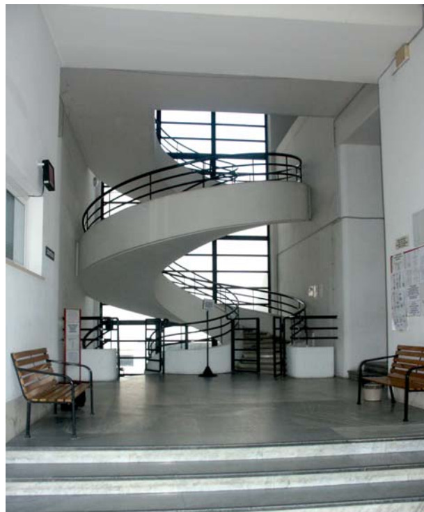
FIGURA 4 • Roma, ex "Casa Gil" a Trastevere. La scala elicooidale che distribuisce gli spazi per aule, ambulatori e palestre accessibili da via Ascianghi in un'immagine attuale.
