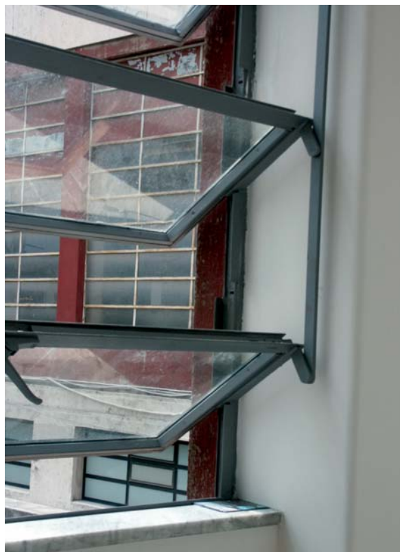
FIGURA 13 • Roma, ex "Casa Gil" a Trastevere. Dettaglio degli infissi delle grandi aperture che illuminano la "galleria degli onori" dopo il restauro. È bastata la sostituzione delle vetrate, la semplice manutenzione e la verniciatura delle superfici metalliche per restituire agli elementi originali piena funzionalità ed efficienza.
