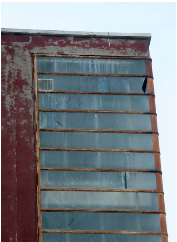
FIGURA 12 • Roma, ex "Casa Gil" a Trastevere. Dettaglio della vetrata che avvolge l'angolo della torre dell'arengo fra piazza Ascianghi e via Induno; infissi e vetrate originali sono stati sostituiti operando pesanti modifiche fra cui il non trascurabile posizionamento di un montante in corrispondenza dello spigolo esterno, in origine del tutto trasparente.
