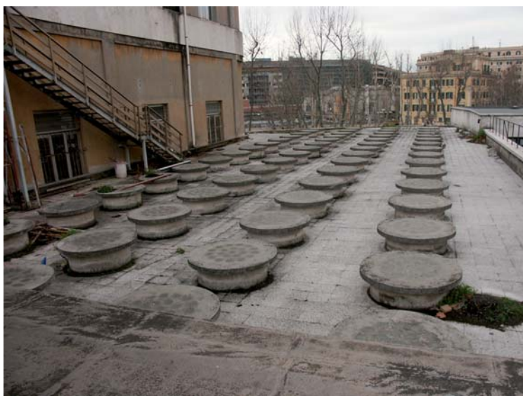
FIGURA 16 • Roma, ex "Casa Gil" a Trastevere. La copertura praticabile sovrastante la grande palestra chiusa, caratterizzata da lucernari a fungo resi trasparenti dalla presenza di formelle di vetro annegate in dischi di cemento armato. Appare insolita la perfetta tenuta all'acqua e all'aria di queste strutture sperimentali che, in altre opere coeve, hanno invece sovente causato infiltrazioni di umidità.
