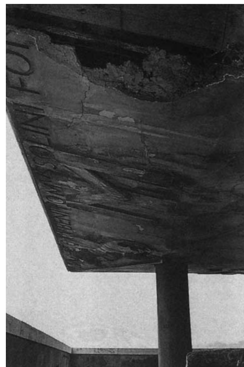
FIGURA 9 • Roma, ex "Casa Gil" a Trastevere. La pensilina posta sulla sommità della torre dell'arengo alla fine degli anni Ottanta (a). All'epoca sull'intradosso della struttura s'intravedevano ancora le raffinate decorazioni a bassorilievo in stucco (b e c) visibili anche dalla quota stradale (Finelli, 1989).
