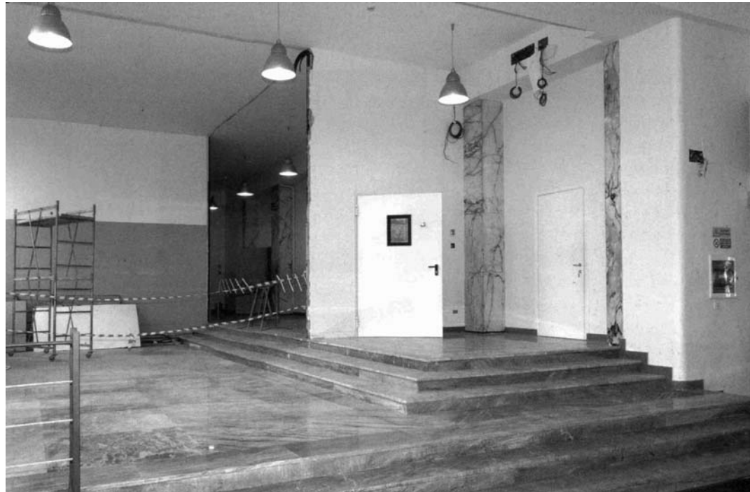
FIGURA 22 • Roma, ex "Casa Gil" a Trastevere. I lavori di rimozione delle pareti aggiunte nella "galleria degli onori".
