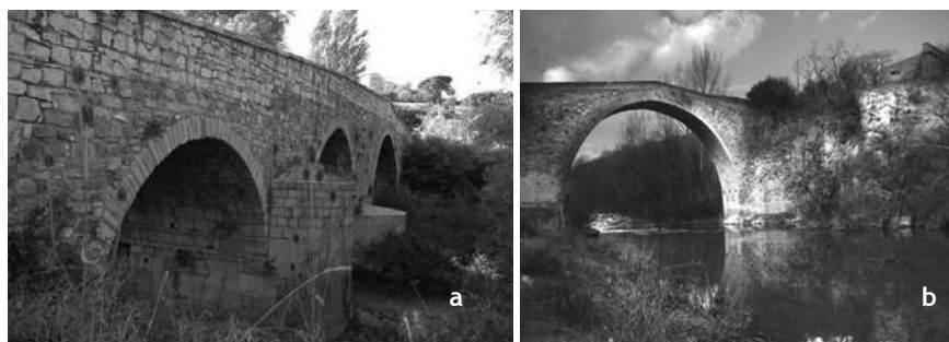
Figure 1. San Vito bridge in Potenza (a) and Della Vecchia bridge in Campomaggiore (b)
