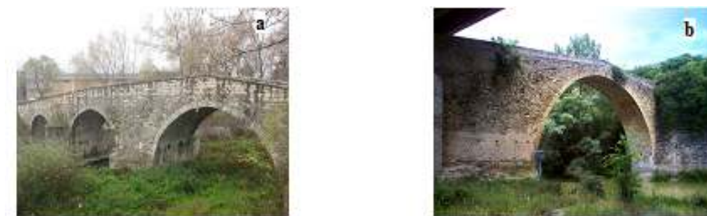
Fig.1: San Vito bridge in Potenza (a) and Della Vecchia bridge in Campomaggiore (b)
