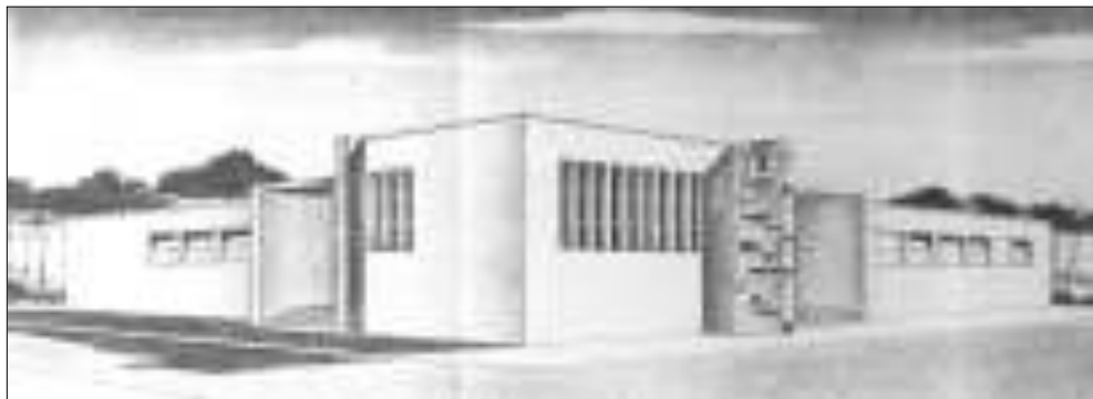
Fig. 3.20 - Vista prospettica della scuola materna di Scanzano Jonoco (MT) - Archivio ERSAP
