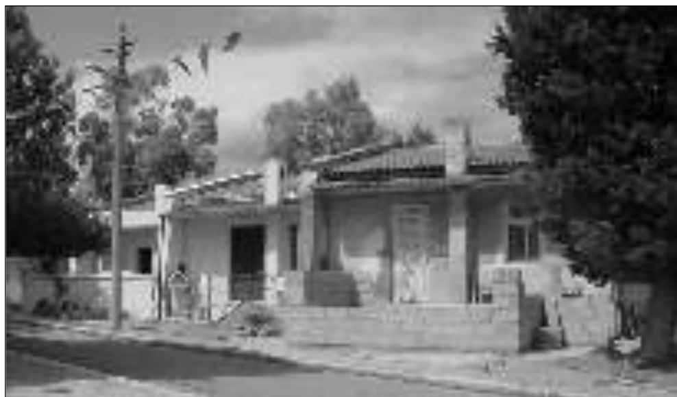
Fig. 6.55 - Borgo Serramarina (MT): Alloggio insegnanti- stato di conservazione
