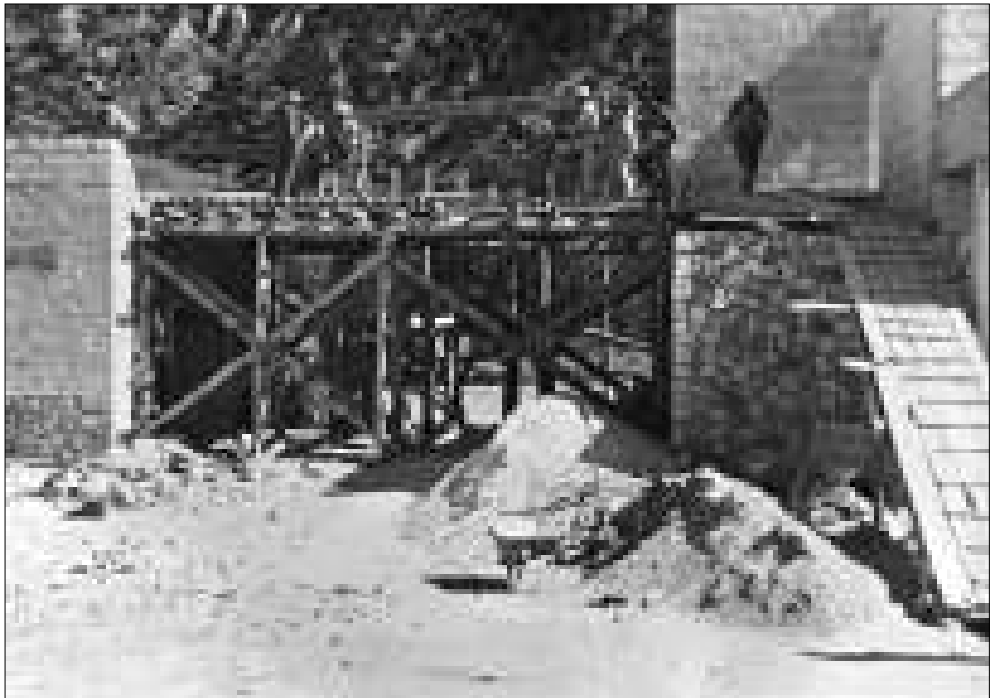
Fig. 5.2 – Foto d'epoca (1954) l'attività di posa in opera degli elementi SAP - Archivio Buonsanti
