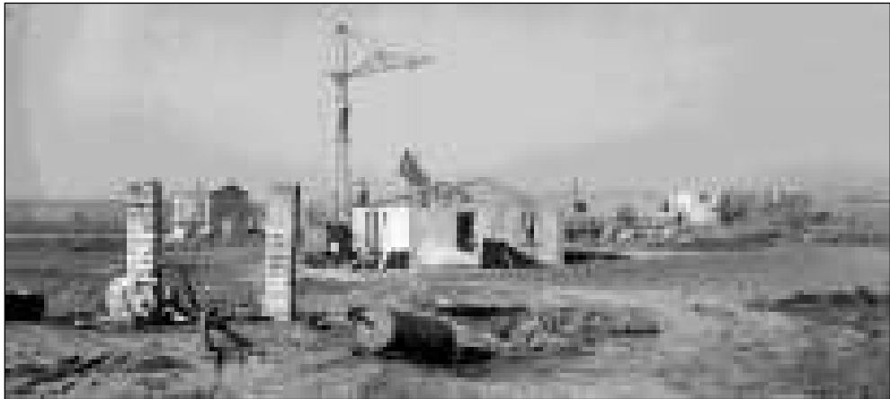
Fig. 6.60 - Campagne del Metapontino su SS 175 (MT) - Edificio prefabbricato: fasi di realizzazione della copertura con capriata in cemento armato ed elementi di timpano prefabbricati - Archivio Buonsanti
