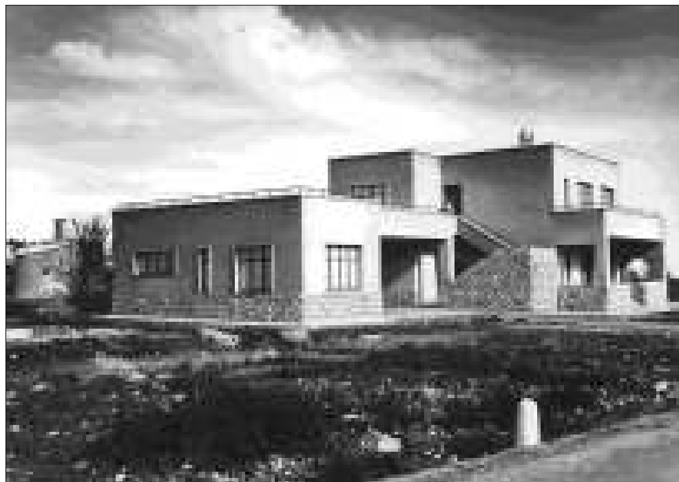
Fig. 6.66 – Casa cantoniera del consorzio di bonifica: zona Alvini Matera – Scala esterna in c.a. (1954) – Archivio Buonsanti
