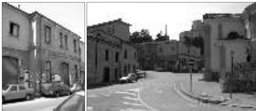
Figg. 2.16 e 2.17 – La caserma oggi. Sono evidenti i blocchi aggiunti
