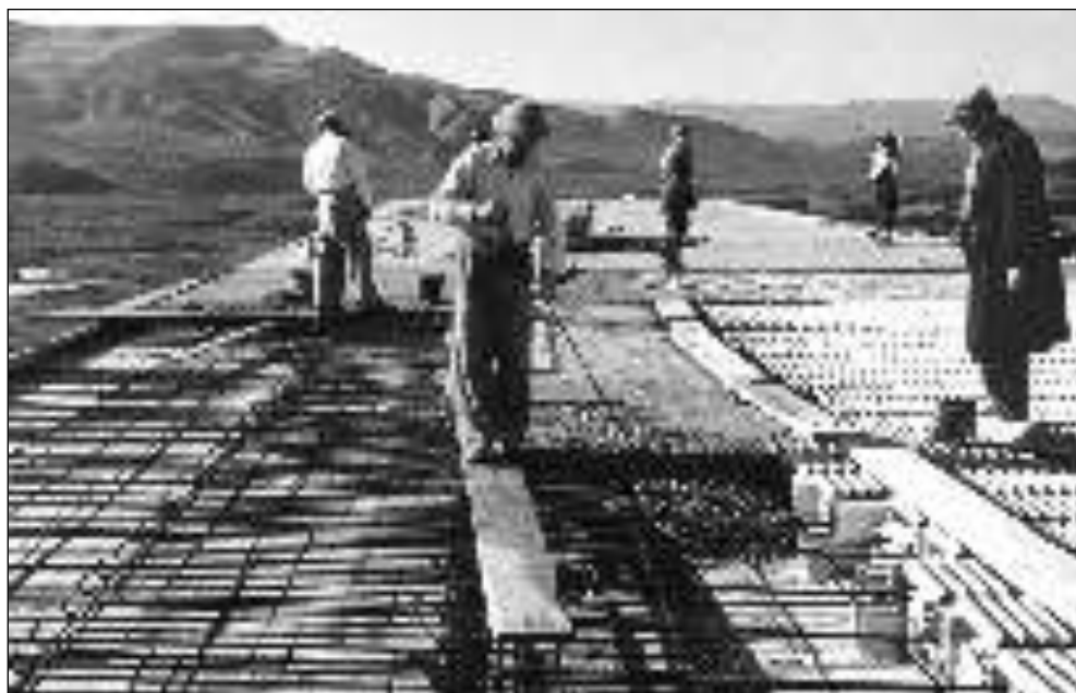
Fig. 6.44 - Borgo Irsina (MT) – Scuola: realizzazione del solaio di tipo misto gettato in opera e con camera d’aria (1952)– Archivio Buonsanti
