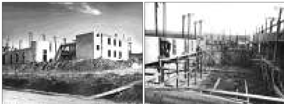
Figg. 6.32 e 6.33 - Borgo residenziale nel demanio di Irsina (MT) - Costruzione chiesa (1954)- Archivio Buonsanti
