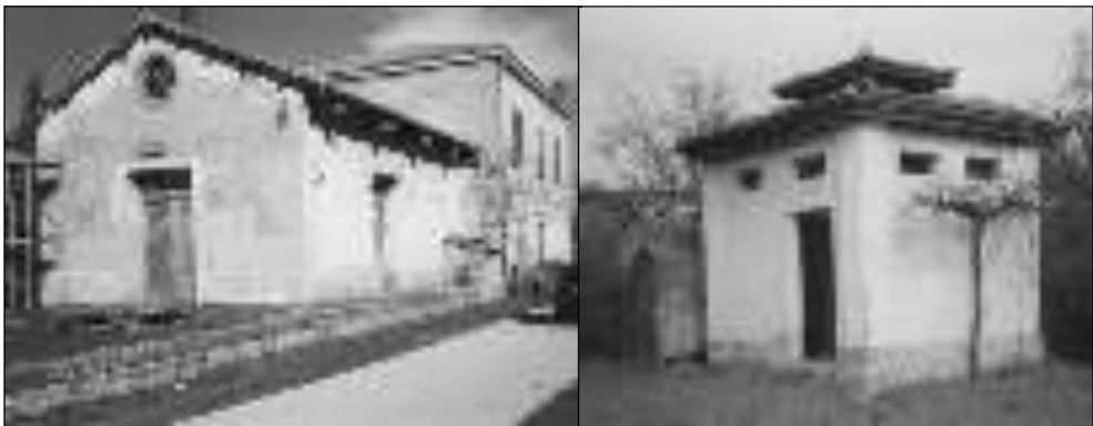
Figg. 2.10 e 2.11 – Stazione e magazzino di Laurenzana (PZ)- Blocco latrine della stazione di Anzi (PZ).
