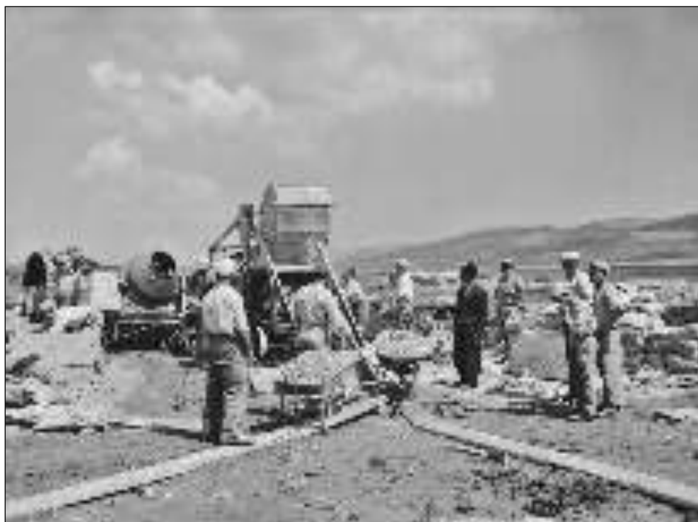
Fig. 6.1 – Fasi di realizzazione di conglomerato cementizio - Archivio Buonsanti
