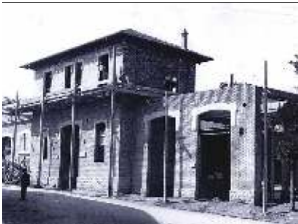
Fig. 2.13 – Caserma fasi costruttive della caserma dei Vigili del Fuoco (1929) - Archivio storico CMC (Cooperativa Muratori e Cementisti di Ravenna)
