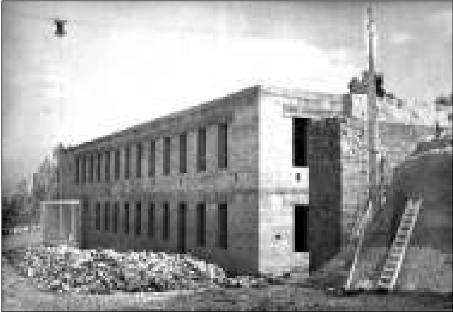
Fig. 6.28 - Borgo residenziale di Metaponto (MT) - Costruzione di un edificio con struttura mista (1955) - Archivio Buonsanti
